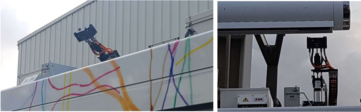
Figura 2 - Pre-posizionamento dell'ETS (foto dimostrativa)
